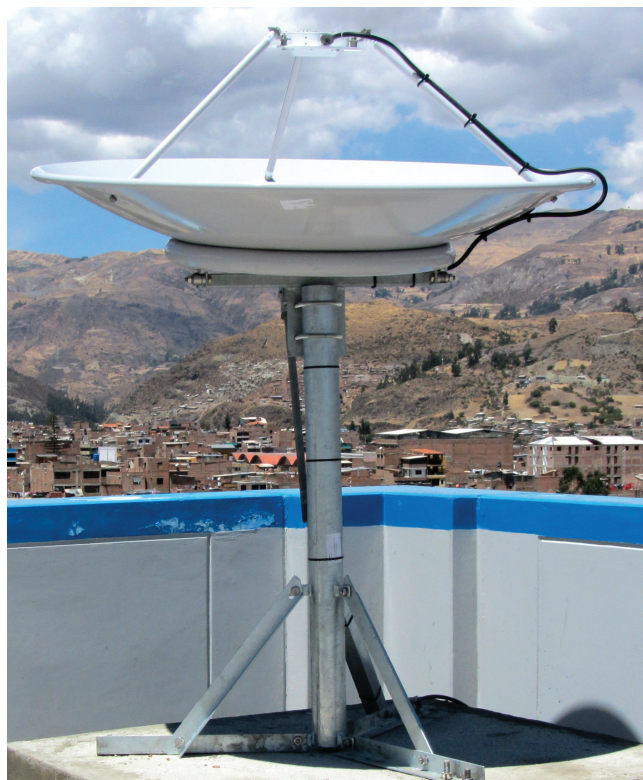
安装在瓦拉斯秘鲁大学Dartcom1.2米L波段天线
